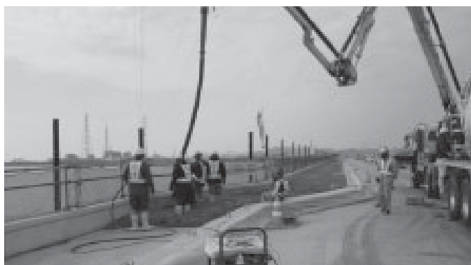
写真16-5 ポンプ打設による施工状況
