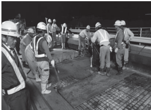
写真14-1 施工例1:橋面調整工
