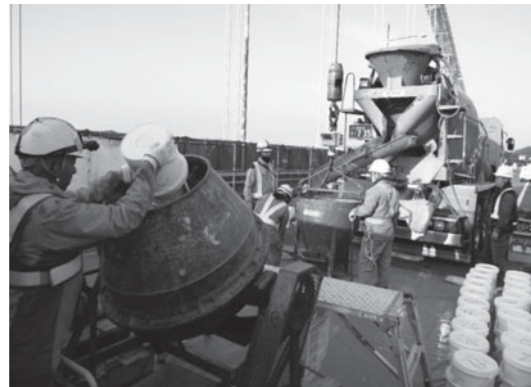
写真14-2 施工例2:既設橋梁の床版打ち換え工
