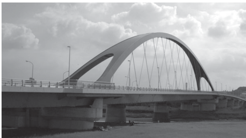
写真16-1 多摩大橋全景
