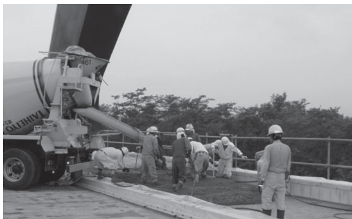
写真16-3 嵩上げコンクリート打設状況
