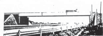
建設当時の花輪跨道橋
