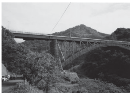
写真15-1 施工例1:工事橋梁の遠景
