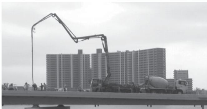
写真16-4 ポンプ打設による施工状況
